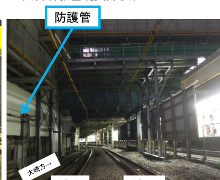
防護管設置後
