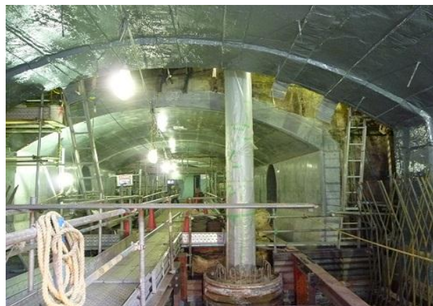
写真-1 RC内巻耐震補強施工状況
