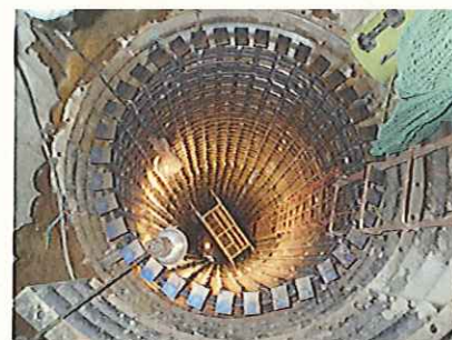
写真-3 深礎杭配筋状況
