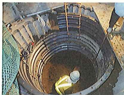
写真-2 深礎掘削状況
