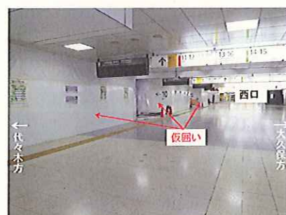
写真-1 北通路仮囲い設置状況
