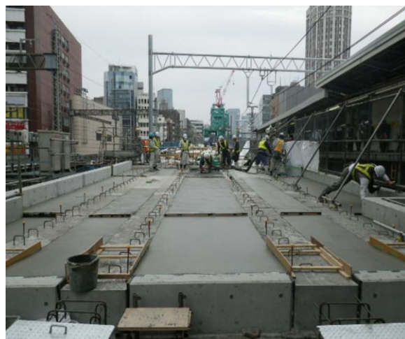
写真1：R17 高架橋施工後
