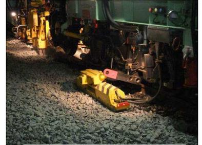
写真-2 サイドコンパクターによる締固め状況
