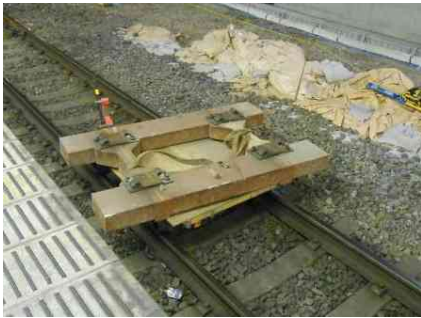
写真-1 特殊マクラギ（井桁型）
