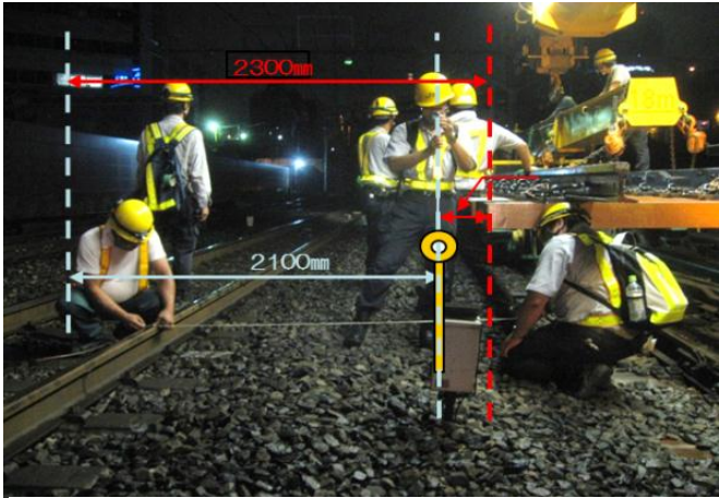
写真2 455イと横須賀線の離隔測定
