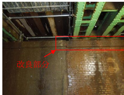
写真-2 橋台境界部
