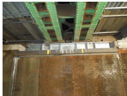
写真-4 旧桁の受替え
