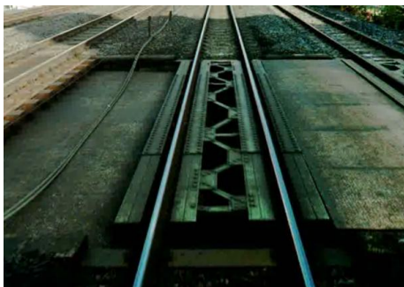
写真-1 旧桁（槽状桁）
