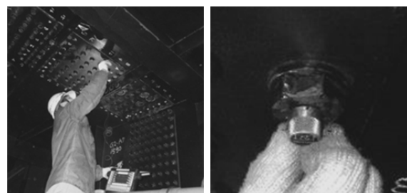
図-6 現場の高力ボルト試験状況
