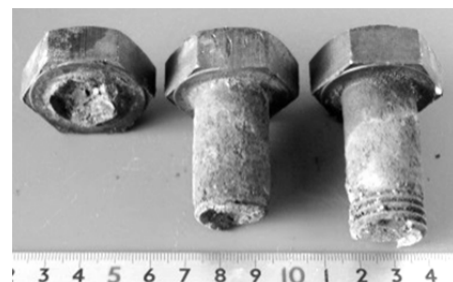
図-3 当現場で発見した破断ボルト
