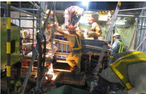
写真-1 打込み試験の様子
