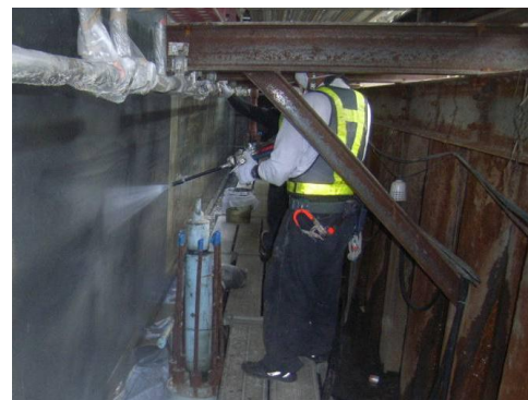
図-4 防水吹き付け状況
