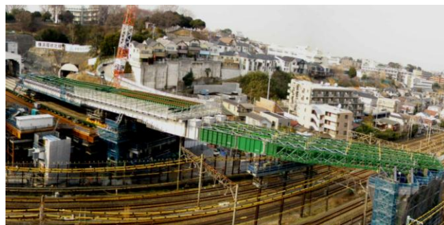
写真-2 第1回送出し完了写真
