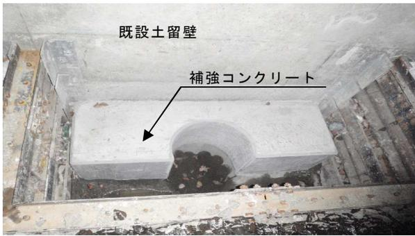
写真-1 既設土留壁補強完了
