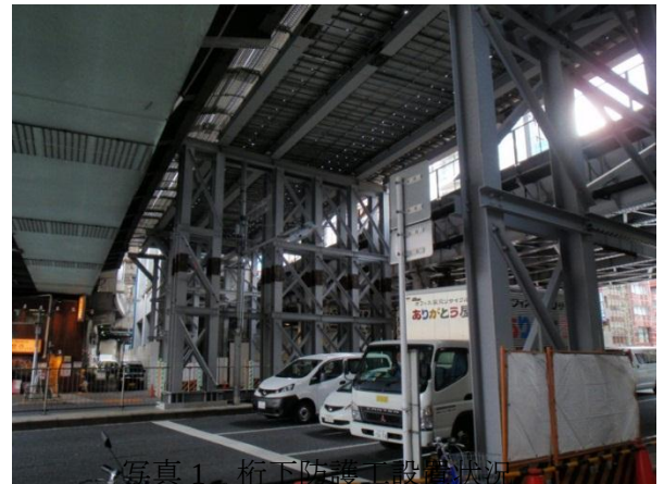
写真 1 桁下防護工設置状況
