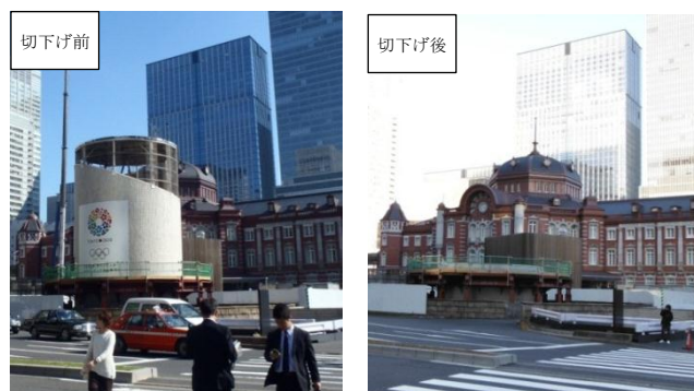
図2 山側換気塔(切下げ前後)
