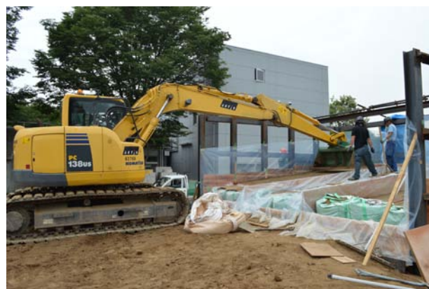
図3 法面バケットによるCB層の施工
