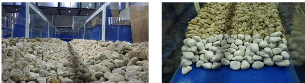
a) 石組み台形断面水路(設置完了の状態) b) 石組み水路下流端での礫の流出防止対策
