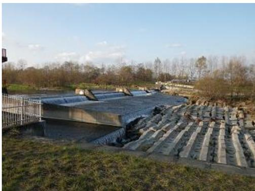
写真1 堰下流側の護床ブロックの流出事例
