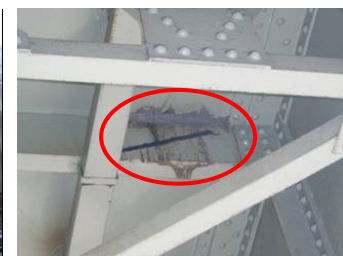
写真2 B 橋りょう（左：全景 右：漏水箇所）
