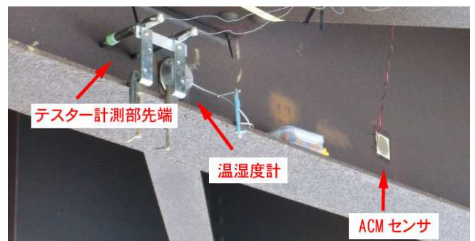
写真-1 機器の設置状況
