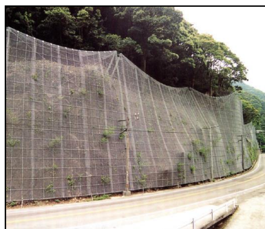
写真-1 落石防護網
