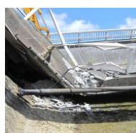
図 2 対象橋梁(辺野喜橋)崩壊後の状況 1)
