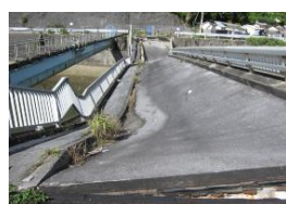
図 2 対象橋梁(辺野喜橋)崩壊後の状況 1)
