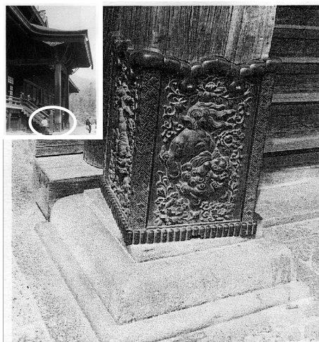
図-1 善光寺本堂の向拝柱の捩じれ 1)
