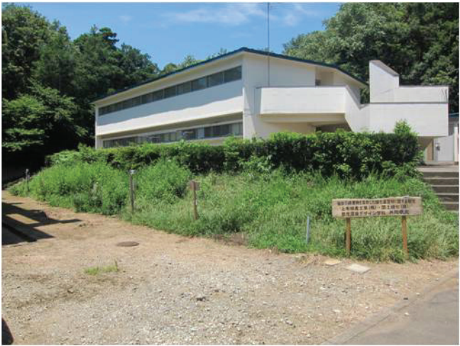
写真-1 構内実斜面の植生状況(7月中旬)
