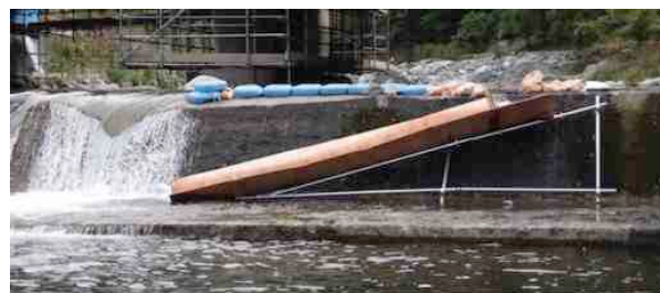
写真 1 2号魚道の設置状況 (堰下流側から撮影)
