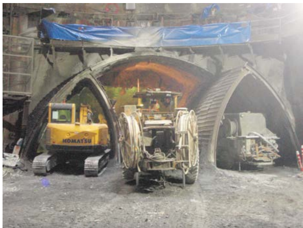
写真-2 西 CNV 上部導坑掘削状況
