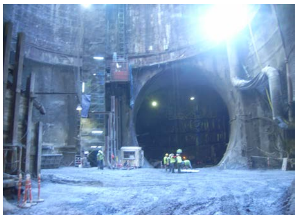
写真-3 西 CNV 掘削完了
