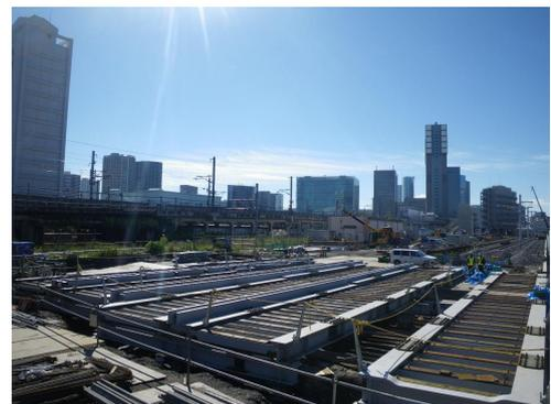
写真 - 1 . 工事桁架設完了
