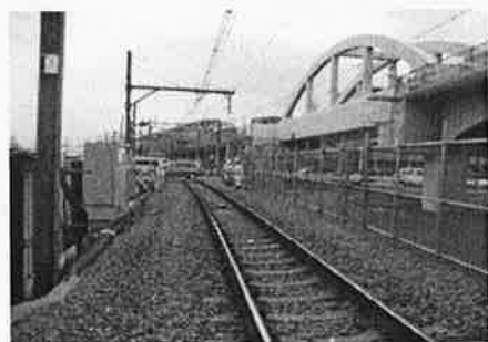
図-6 仮上り線より高架上り線施工箇所を望む
