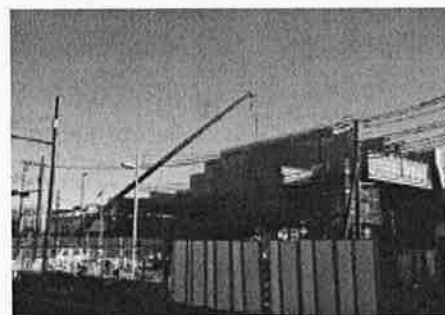
図-8 作業用構台を利用したクレーン作業
