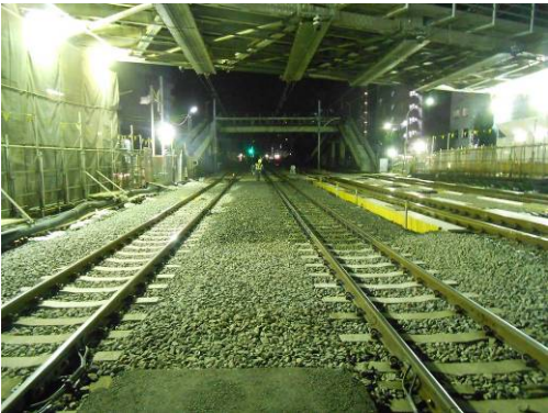
写真－3 山手貨物線工事桁撤去完了
