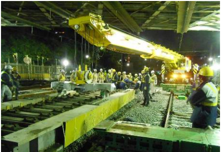
写真-2 工事桁一括撤去工
