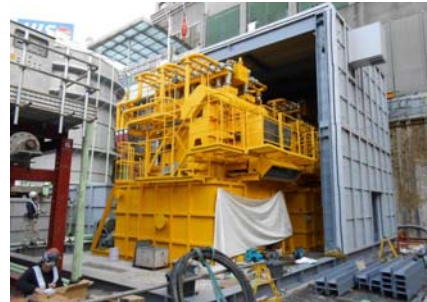
写真4 防音ハウス設置状況
