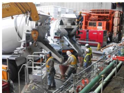
写真7 コンクリート打設
