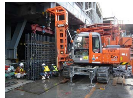
写真5 鉄筋かご建込
