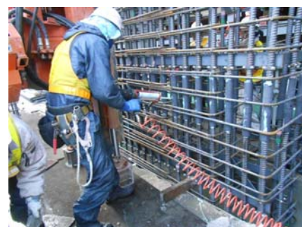
写真6 鉄筋かご継手
