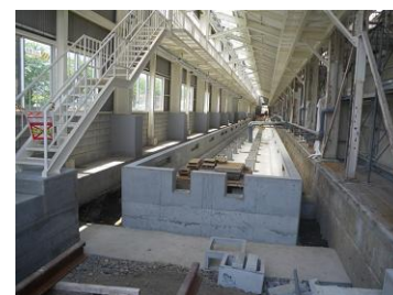
写真-3 検修坑施工後
