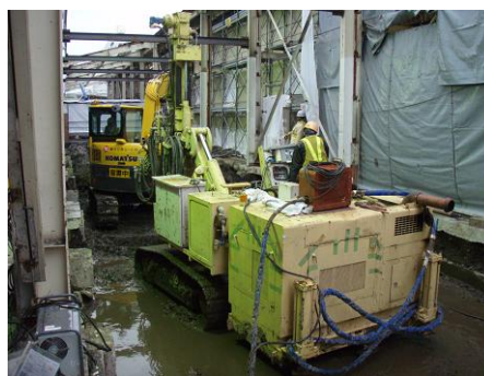
写真-4 地盤改良施工状況
