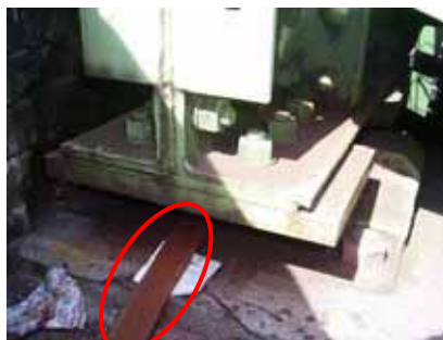
写真-3 応急修繕
