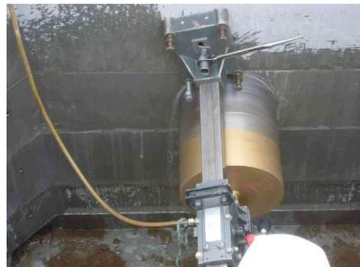
図-2 接続部コア抜きの様子 (φ=300mm)
