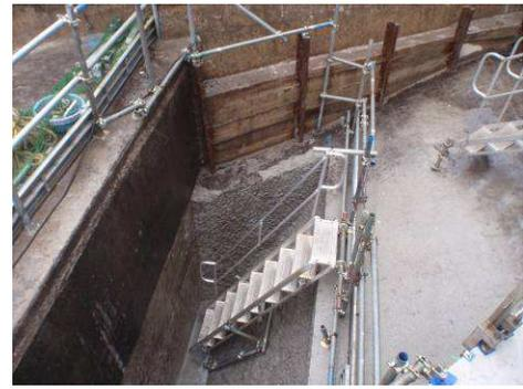
写真-1 中詰めコンクリート・バラスト撤去状況
