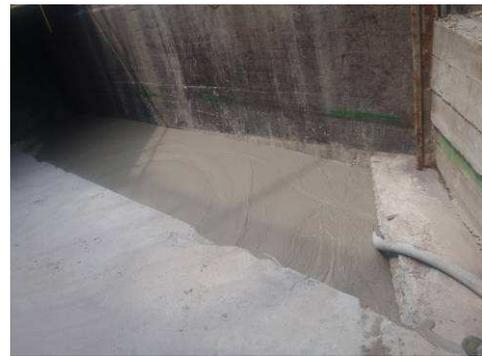
写真-2 気泡モルタル打設状況
