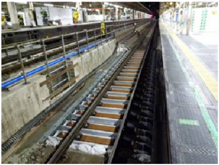
写真 - 2 工事桁架設完了
