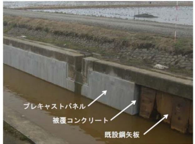
図-1 構造概要図
