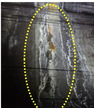
写真-1 補修後の再漏水の状況
