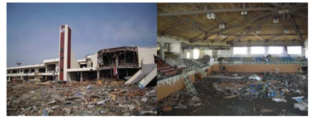
写真-1 陸前高田市市民体育館(2011年3月20日撮影)
