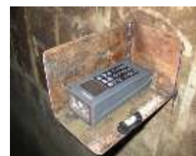
図-4 レーザー変位計を固定する治具の設置例
