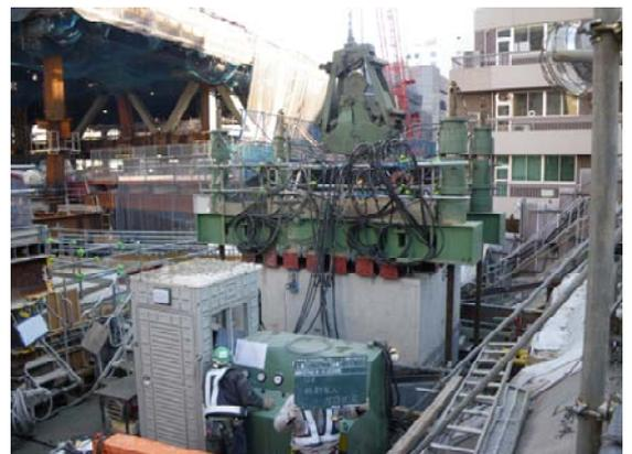
写真-1 掘削圧入状況
