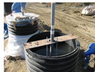
図-6 浸透実験装置
