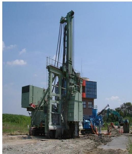
写真 1 ソイルセメント連続壁の施工写真
