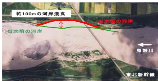
写真-1 平成13年9月東北新幹線橋梁付近
