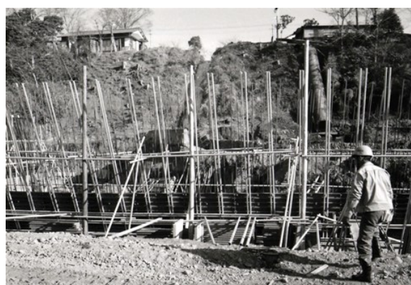
図-5 大滝（施工中） 10)
