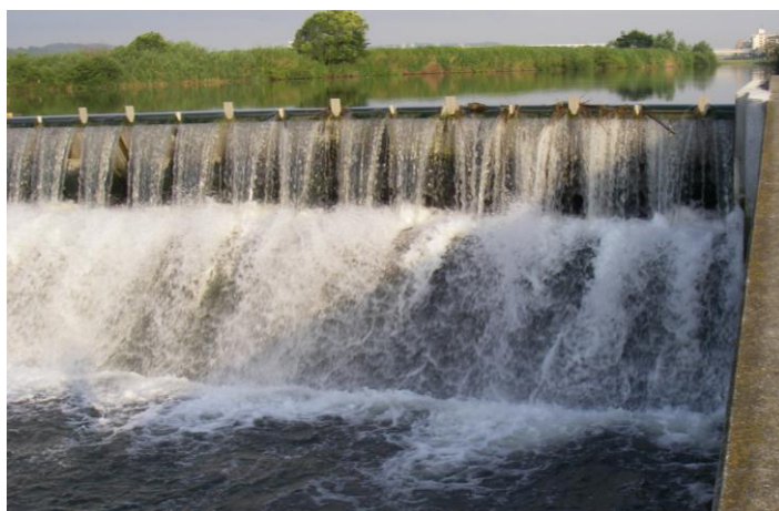
写真 1 二ヶ領上河原堰の可動堰
