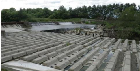
写真 1 堰下流側における護床ブロックの流出事例
