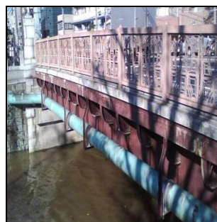
図-1 対象道路橋
