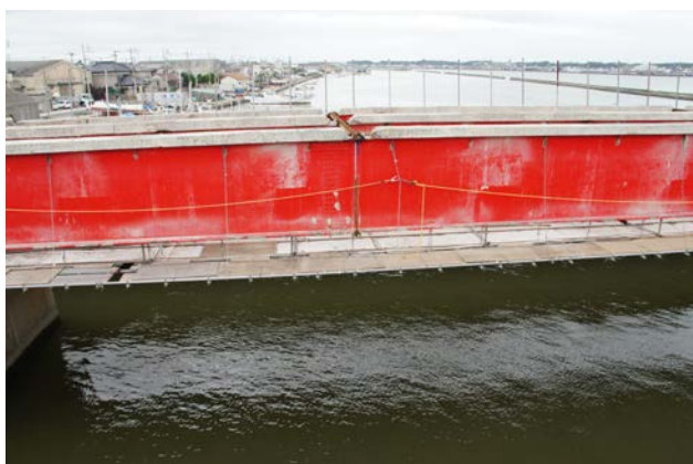
写真－7 上フランジに設置した仮支材 (隣径間における準備作業状況)
