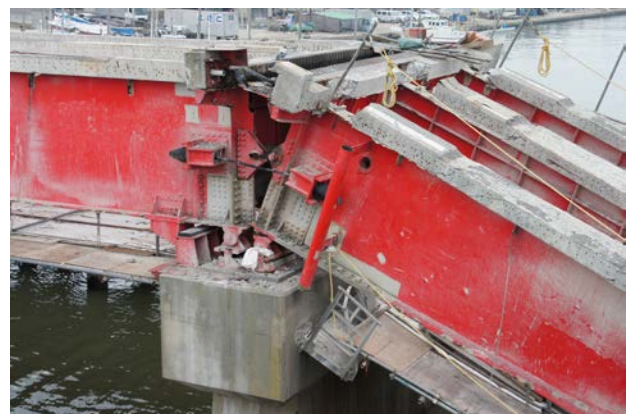
写真－2 落橋防止装置の存在
