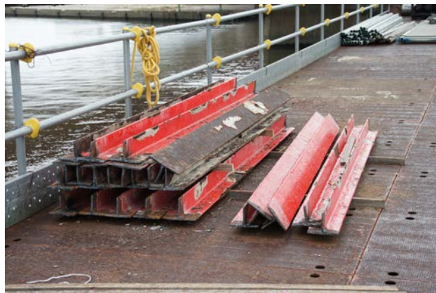
写真－6 撤去された対傾構の一部
