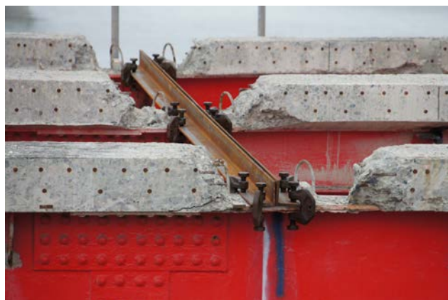
写真－8 上フランジに設置した仮支材 (隣径間における準備作業状況)
