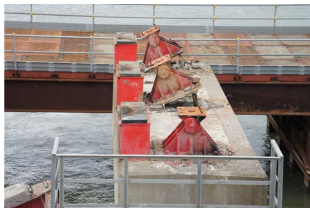
写真－4 河川中央側の橋脚上の支承
