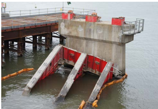
写真－3 河川中央側の橋脚上の支承
