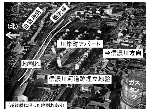
図-9 県営川岸町アパート付近の被害写真 9)
