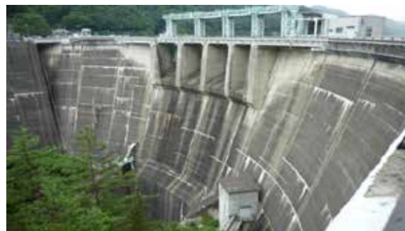
写真-1 左岸アーチ
